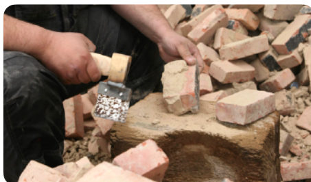
Nettoyage manuel des restes de mortier
