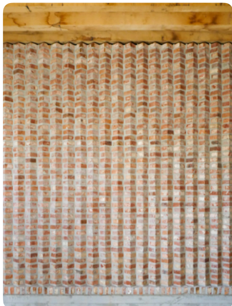
Parement mural intérieur en briques de réemploi. Zonnige kempen (BE).
