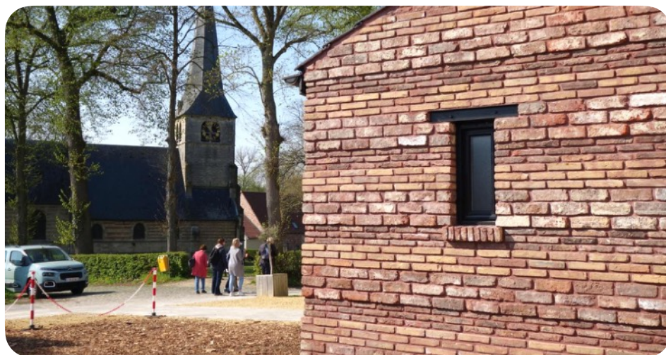
Appareillage d'une façade avec trois modèles différents de briques de réemploi. Chiro Itterbeek (BE) © ROTOR
