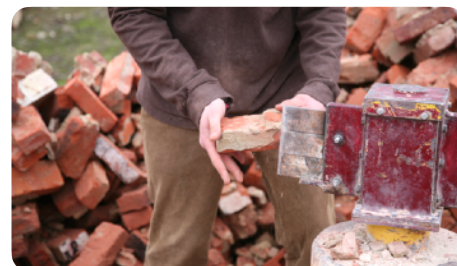
Nettoyage mécanique des restes de mortier
