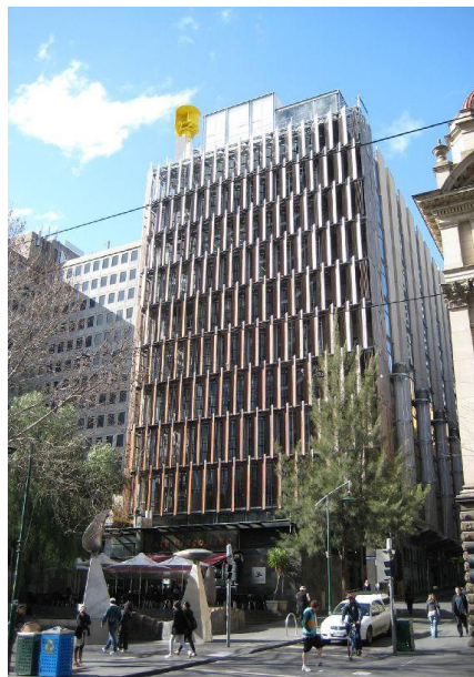
Fig.II.22 Vue sur la façade ouest du bâtiment CH2 avec les volets automatiques en bois (Source: www.mickpearce.com )
