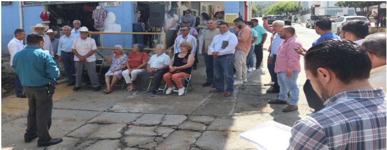
Arranque de obra calle Mártires del Tacamo, Minatitlán, Colima.
