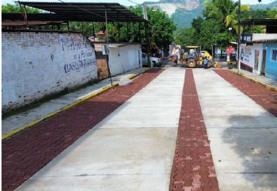
Rehabilitación Integral de la calle 27 de Octubre, Cabecera Municipal.
