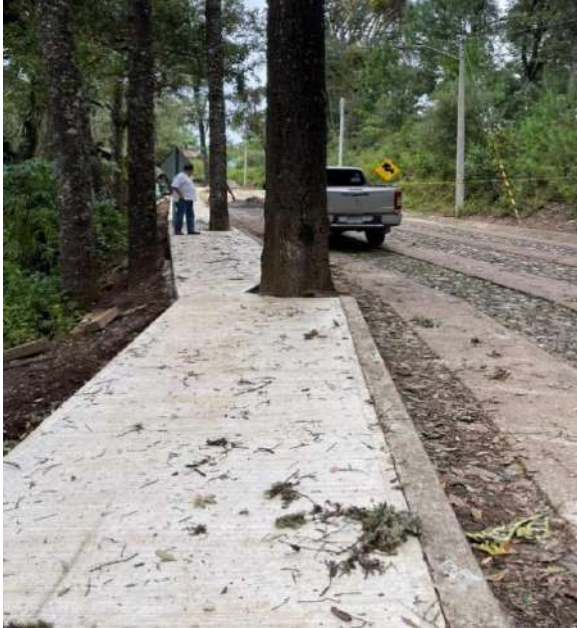
Construcción de guarniciones y banquetas en la localidad de El Terrero.
