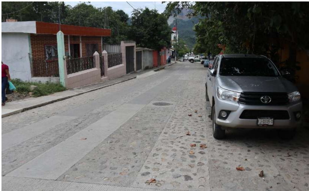
Empedrado ahogado con mortero calle Juárez, Minatitlán, Col.
