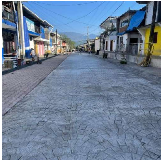
Rehabilitación Integral de la calle Mártires de Tacamo, entre las calles Juárez e Independencia.
