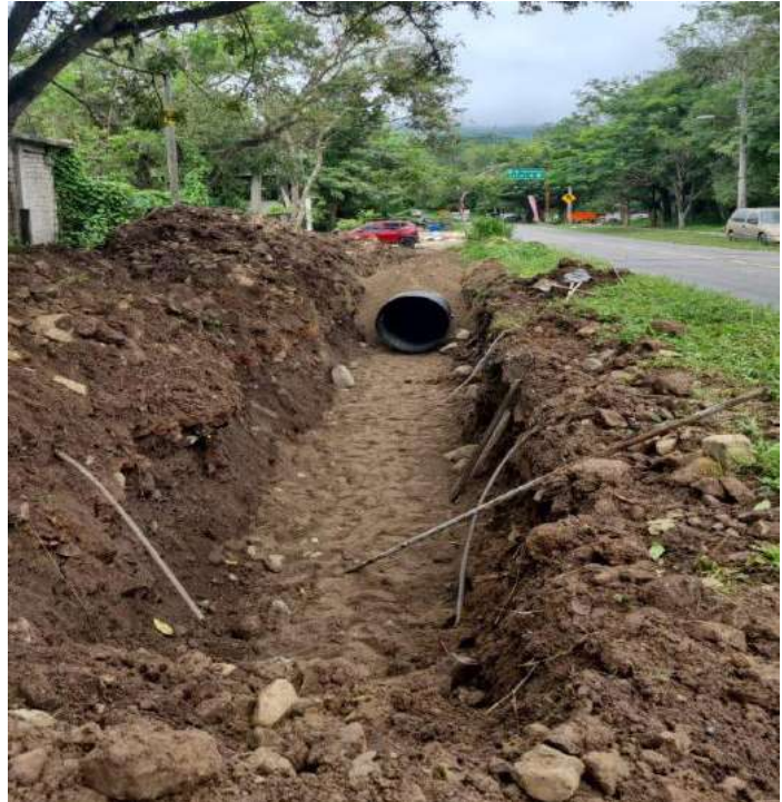
Construcción de red de alcantarillado en la calle Quincuagésima Legislatura
