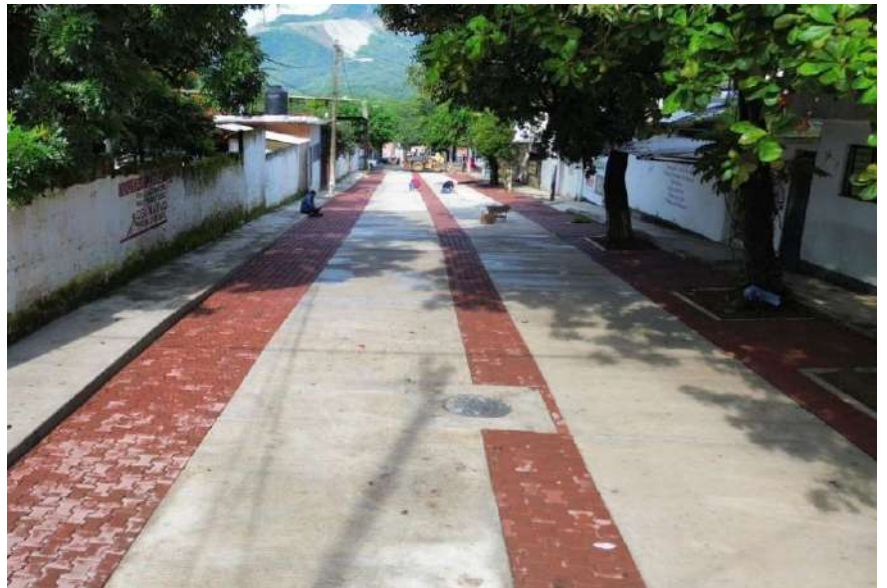
Rehabilitación Integral de la calle 27 de Octubre, Cabecera Municipal.
