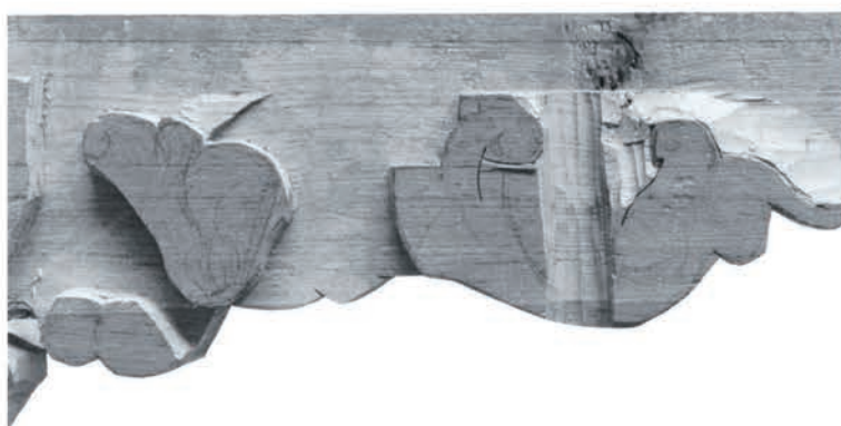
13. Défonçage au niveau de la moulure inférieure
