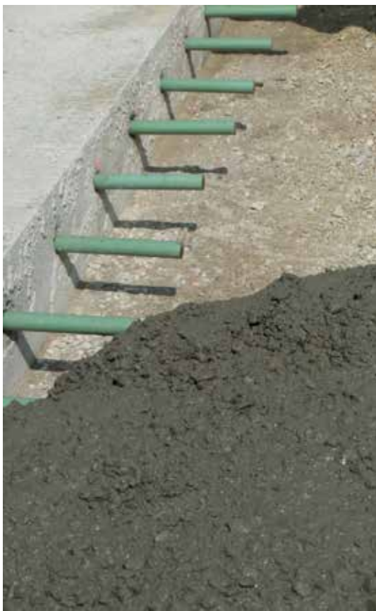
Joint de construction transversal goujonné
